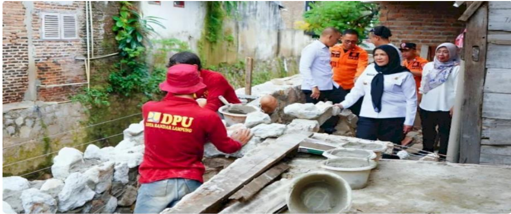
Wali Kota Bandar Lampung Eva Dwiana meninjau perbaikan saluran drainase/1st
