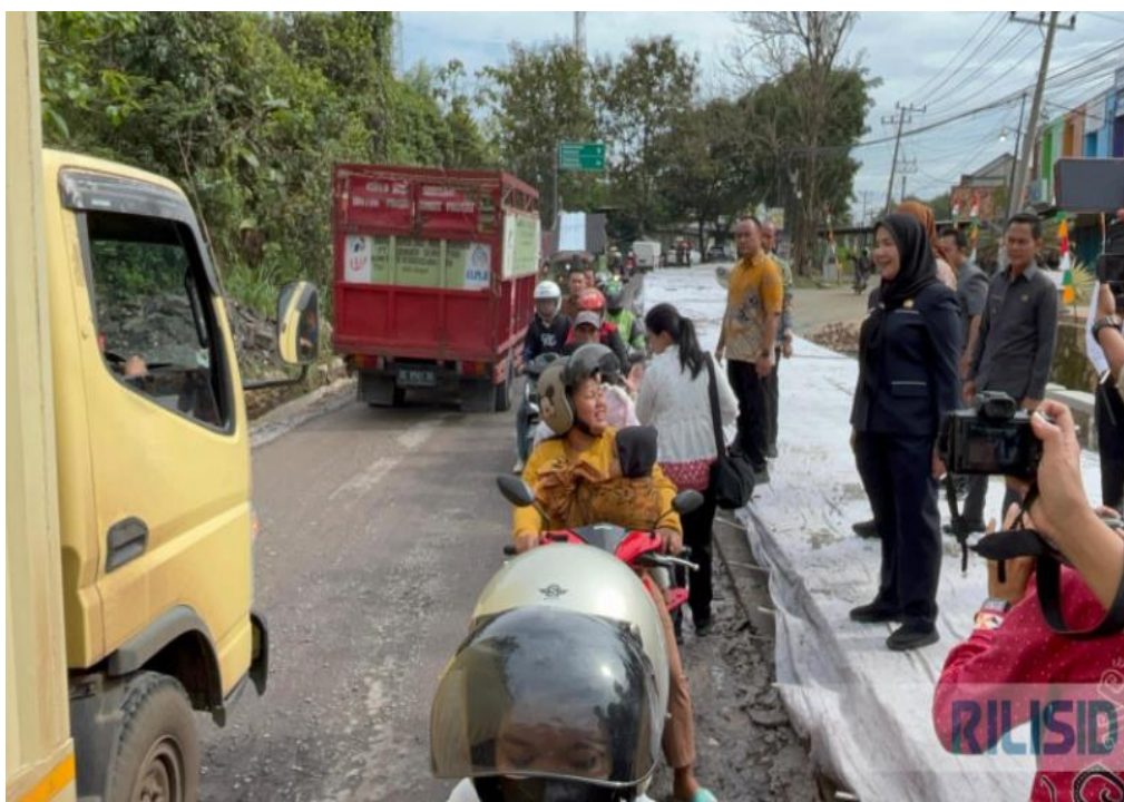
Wali Kota Bandar Lampung Eva Dwiana tinjau lokasi perbaikan jalan Tirtayasa, Kamis (19/6/2025).
