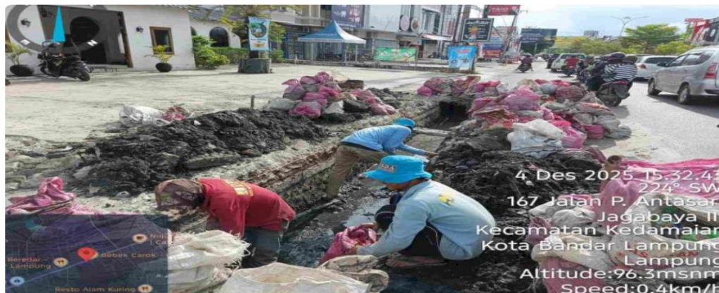
Pembangunan drainase di Kota Bandar Lampung/dok Dinas PU
