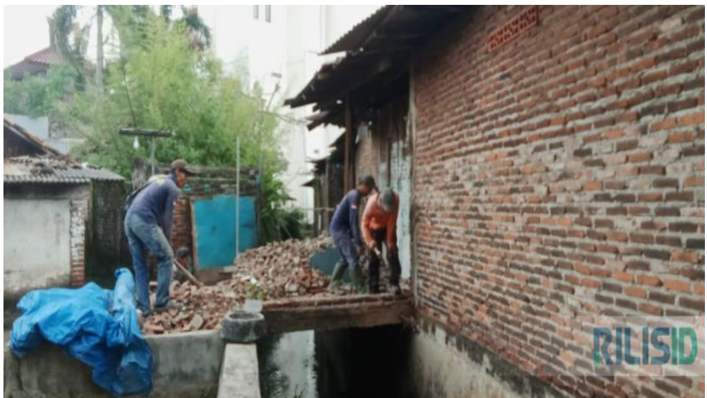
Pembongkaran bangunan diatas drainase yang melanggar Garis Sempadan Sungai (GSS) di Kecamatan Kedaton
